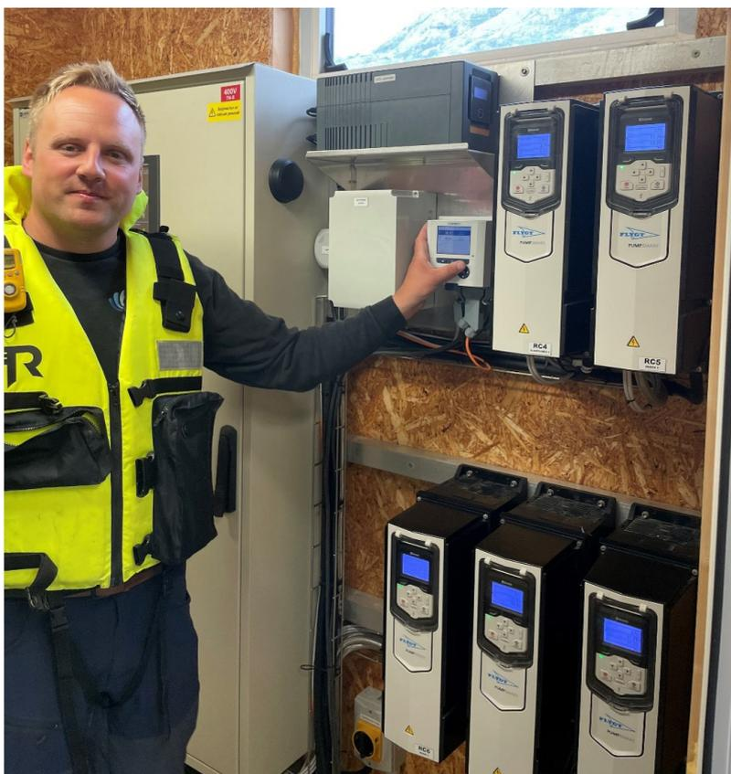
Ein WTW-Controller mit Display sorgt zusammen mit Frequenzumrichtern für die Flygt-Pumpen für eine sichere Versorgung der Fischkäfige mit sauberem Wasser ohne Seeläuse.
